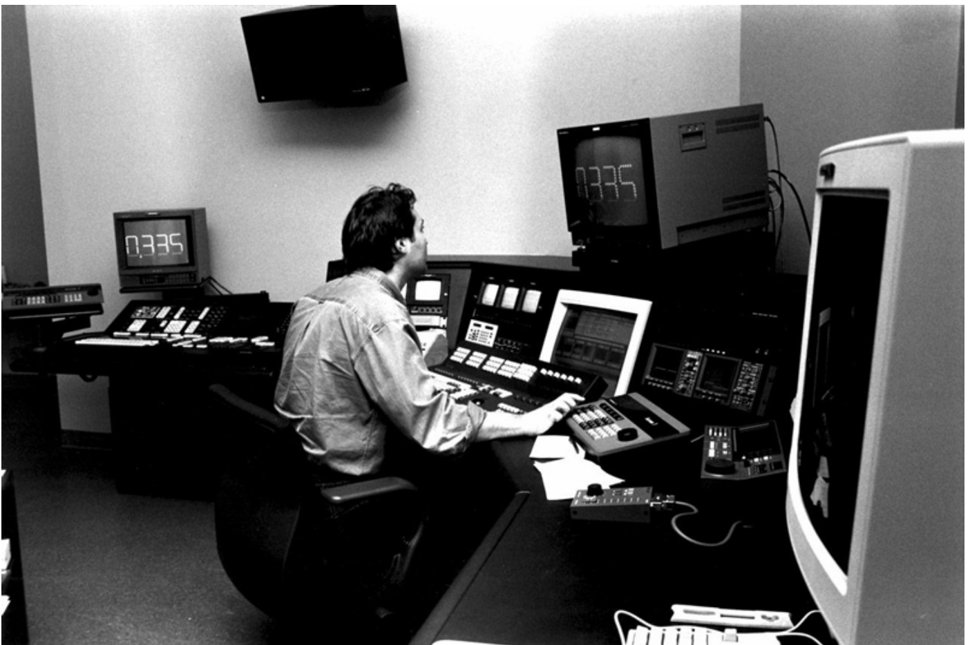
Imagen de 1987, donde puede observarse cómo la impresora óptica analógica era gestionada por medio de procesos basados en tecnología digital, alcanzando con ello su máximo grado de desarrollo.
